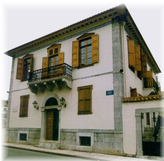
Εξωτερική άποψη του κτιρίου Καρυωτάκη
